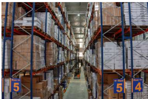
Centro de Distribuição Duque de Caxias - RJ
