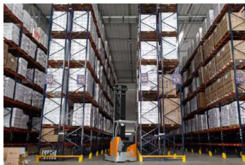
Centro de Distribuição Itajaí - SC
